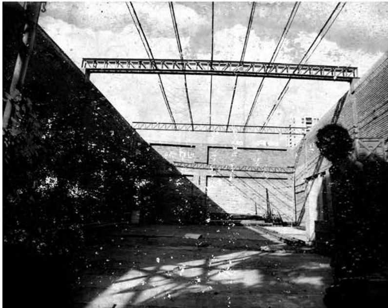
Construcción sala independiente. 1972.
